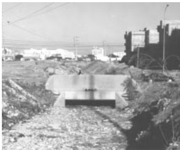
Comblement en cours de l'oued Lahouar au niveau du pont Moussaïfir
